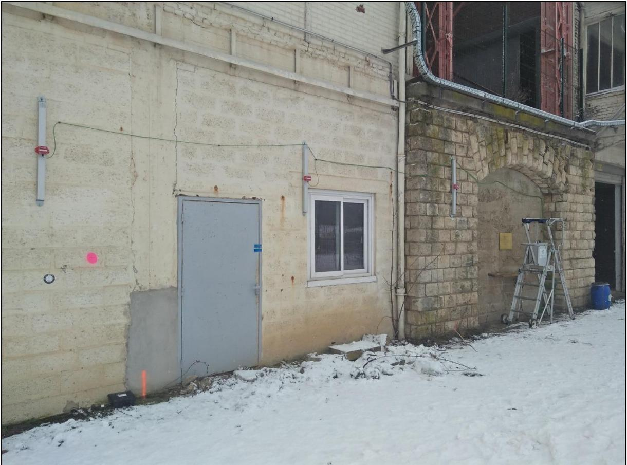
Figure 2 – Exemple de suivi par capteurs inclinométriques sur barre
