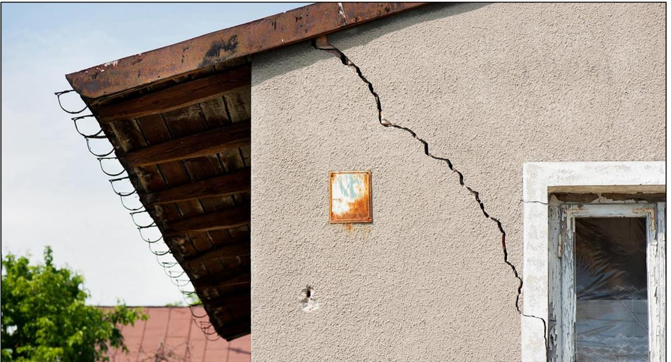
Figure 2 – Exemple de fissure sur bâti
