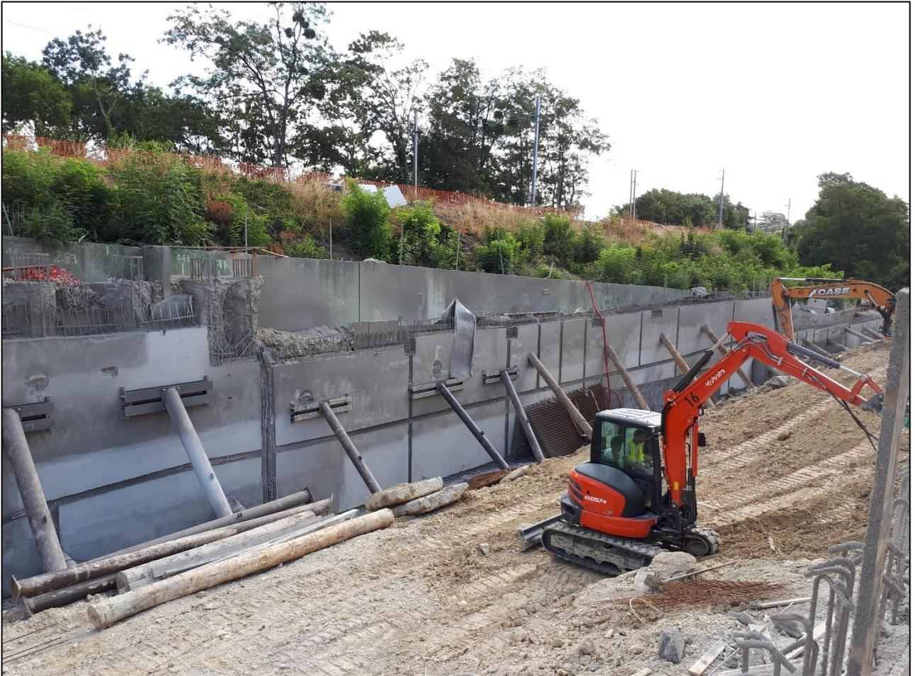
*Figure 2 – Exemple d'une paroi butonnée par poutres acier*
