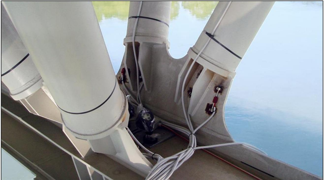
Figure 5 - Exemple de jauges soudées sur une structure de pont
