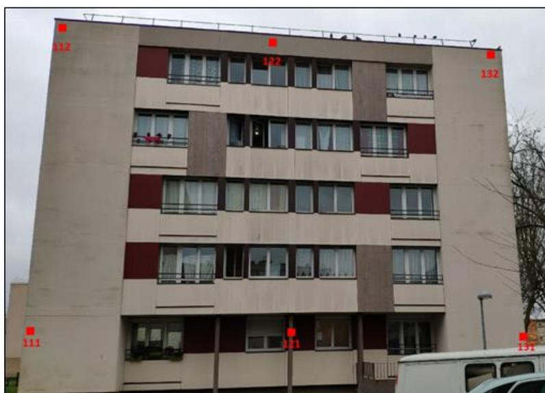
Figure 3: Auscultation manuelle d'un bâtiment d'habitation – Vigneux sur Seine (2020)
