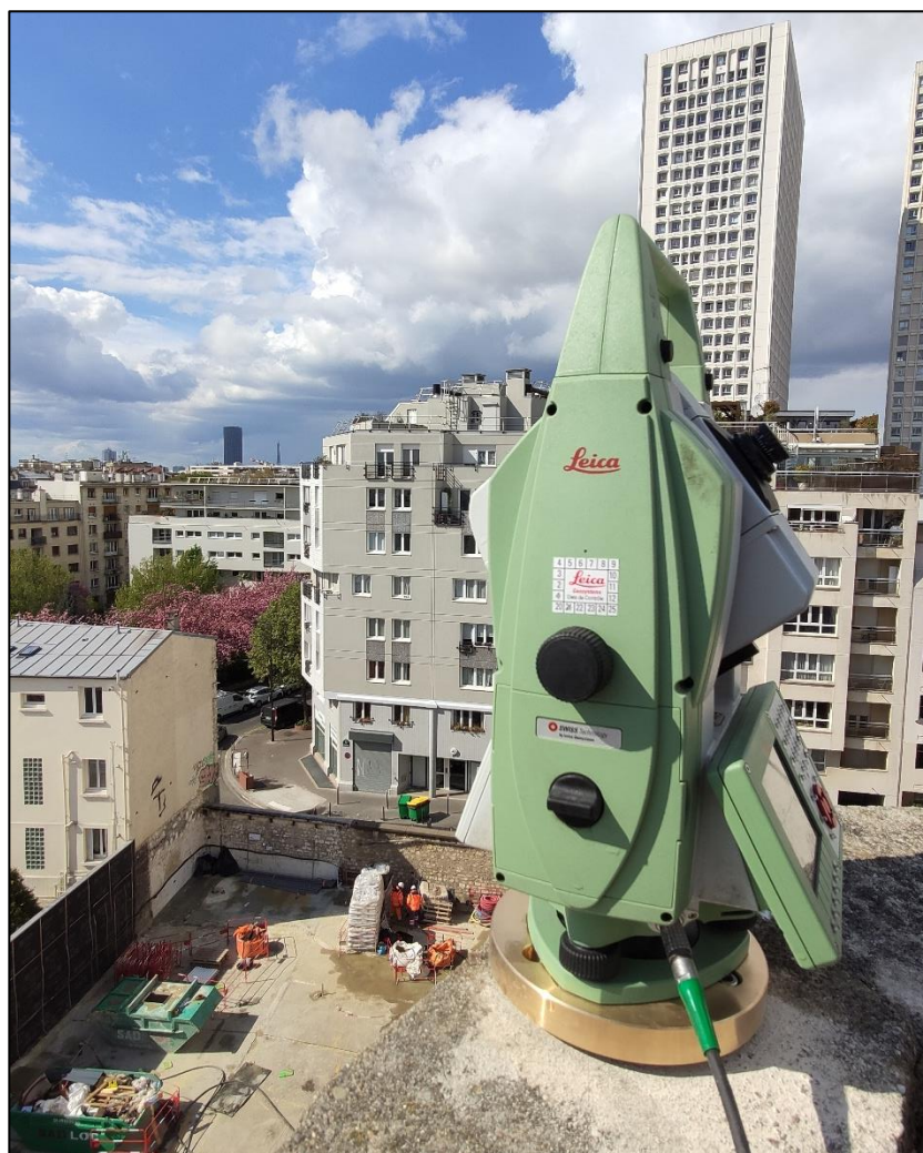
Figure 5 – Auscultation de façades de bâtiments avoisinant un chantier de construction – Paris (2021)
