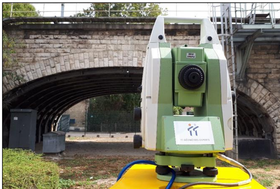
Figure 2: Auscultation automatique d'un pont rail SNCF – St Ouen (2018)
