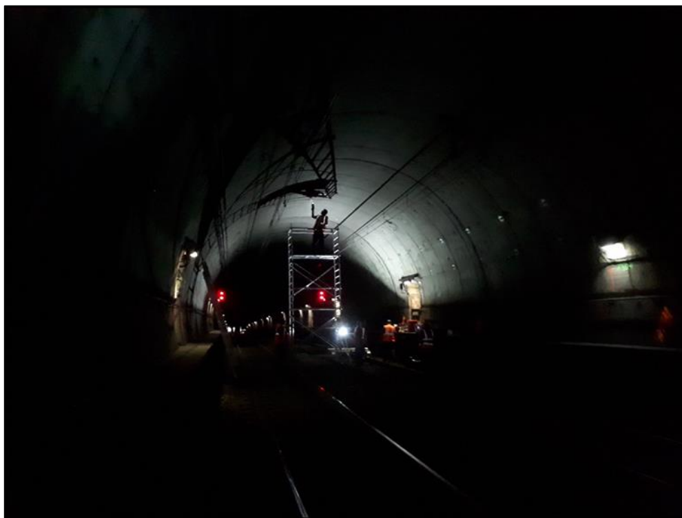
Figure 3 : Auscultation automatique du tunnel RATP – Noisy Le Grand (2019/2020)
