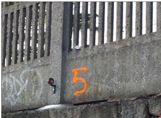
Figure 14 – Exemples de prismes installés
